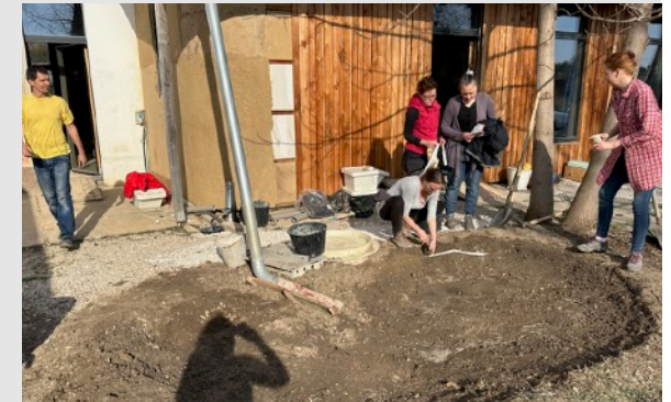
Osadenie prívod dažďovej vody. Presnejšie dotvarovanie dažďovej záhrady.
