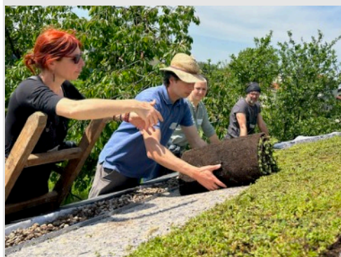
Rozloženie sukulentového predpestovaného koberca.
