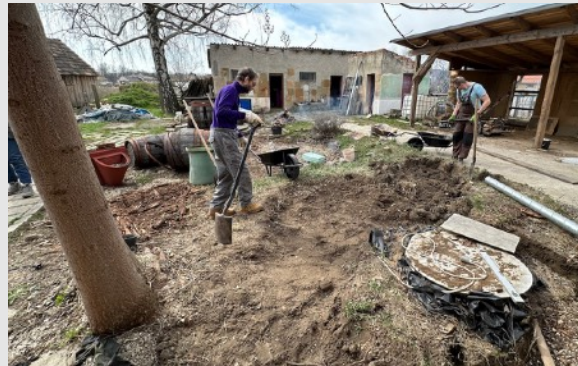
Hrubá úprava terénu, vykopanie preliačieny.
