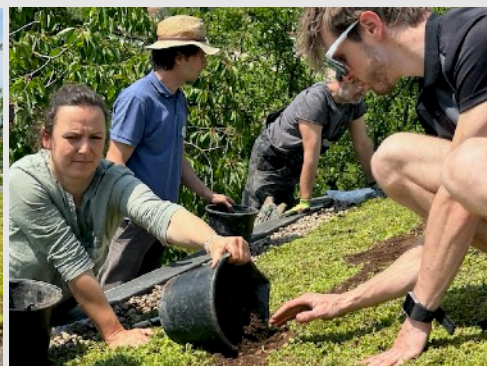
Namiesto koberca doplnenie priestoru strešným substrátom pre extenzívne strechy.
