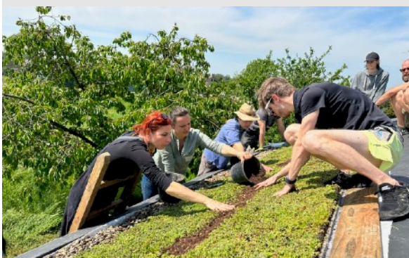
Zelená strecha a oživenie sukulentového koberca rôznymi druhmi rozchodníkov.
