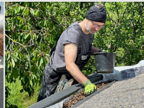
Oloženie štrku po okrajoch strechy, vymedzených štrkovou kovovou lištou, zaťaženou vrstvami zelenej strechy.
