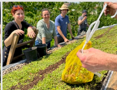
Posadenie odrezkov sukulentov (sedum) do substrátu.
