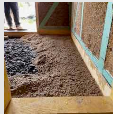
Polosuchú zmes vysypeme priamo na penové sklo.
