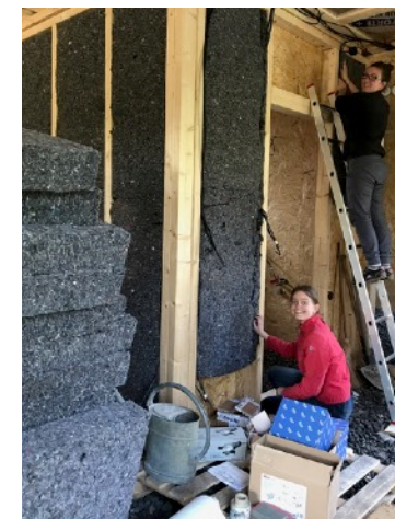
Výplň drevených rámov mäkkou textilnou izoláciou (alebo drevovláknom, konope). Priečka sa zaklopí z oboch strán OSB doskami.
