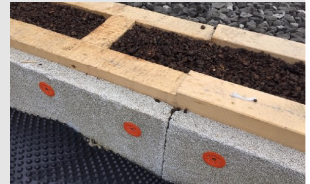
Dutina Venca sa vyplní tepelnou izoláciou, napríklad dreveným korkom.
