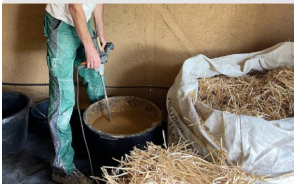
Rozmiešame ílovú hlinu s vodou, a pripravíme tak riedku ílovitú kašu.
