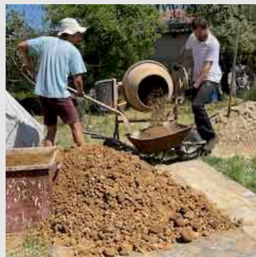
Na miešanie je vhodná miešačka s núteným horizontálnym miešaním, ale zvládne to aj spádová miešačka.
