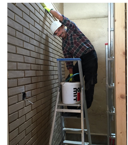
Priečka murovaná hlinenými tehliami na hlinenú maltu.
