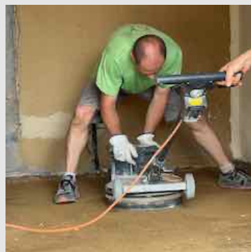
Následne ešte v čerstvom stave povrch brúsime brúskou na betón do požadovanej kvality povrchu.
