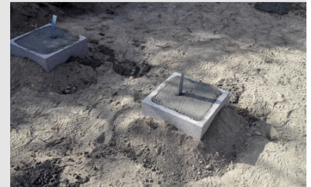
Betónové duté tvárnice boli osadené do roviny a zaliate betónom naraz s pilótami. Hneď sa vložili aj pásy na uchytenie dreveného venca.
