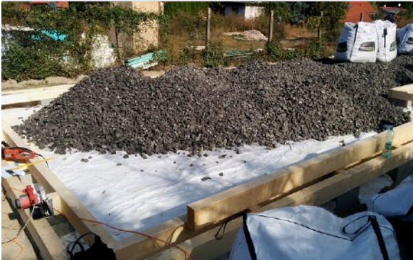
Penové sklo sa oddelí od zemiary geotextíliou.
