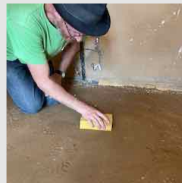
Po vyschnutí vyčistíme povrch spongiu/molitanovým hladítkom a odhalíme kamienky.
