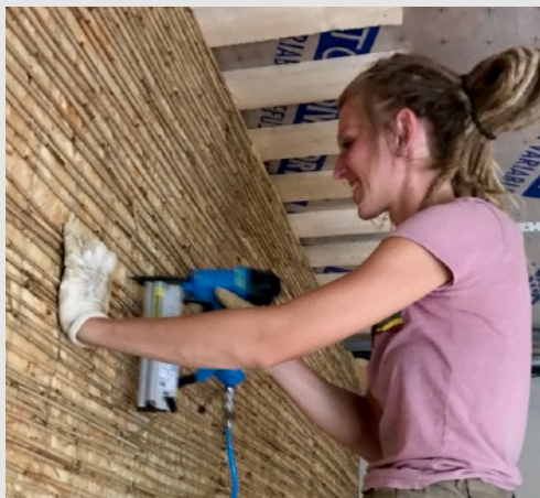
Ak sa ako záklop použije OSB doska a chceme ju omietať hlinenou omietkou, treba na OSB prichytiť rákosovú rohož ako nosič omietky.
