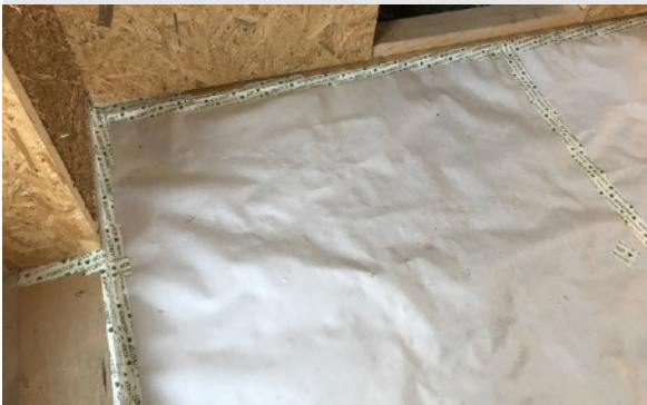
Alebo sa na vyrovnanú vrstvu položí vzduchotesná paropriepustná membrána, ktorá sa prilepí a základ priečok a stien.
