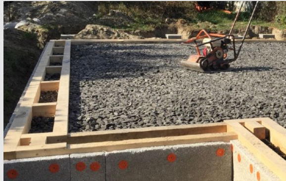
Penové sklo sa udusá žabou/ vibračnou doskou.
