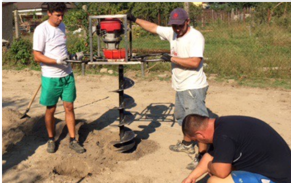
Vyhĺbenie jám pre pilóty pneumatickým vrtacím strojom do hĺbky 1m.
