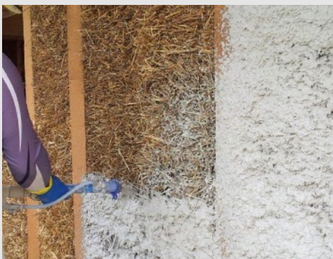
Nastrieka sa prvá vrstva - príľnavostná
