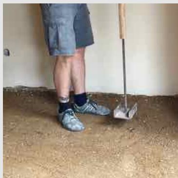
Okraje a rohy ubijeme pomocou vyrobeného ubíjacieho kladiva.
