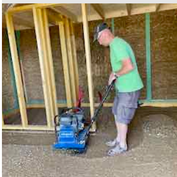
Potom zmes ubijeme pomocou vibračnej dosky.
