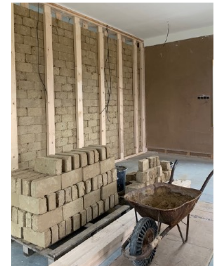
Stavba protipožiarnej a akustickej priečky medzi dielňou a apartmánom.
