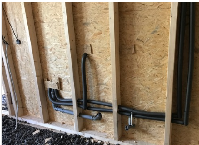
Rámová drevená konštrukcia môže byť nosná aj nenosná. Nevýhodou je pracnejšia inštalácia potrubí a káblov.
