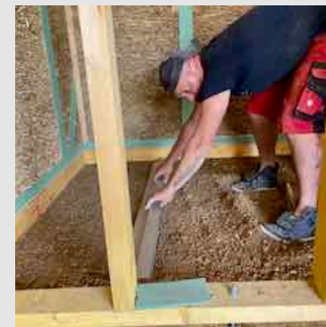
Zmes zarovnáme vyrovnávacou latou a vodováhou.
