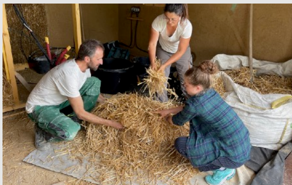
Slamu zmiešame s malým množstvom ílovitej kaše tak, aby boli steblá kašou mierne navlhčené. Najlepšie je, spraviť si najprv vzorku, aby sme určili správny pomer.
