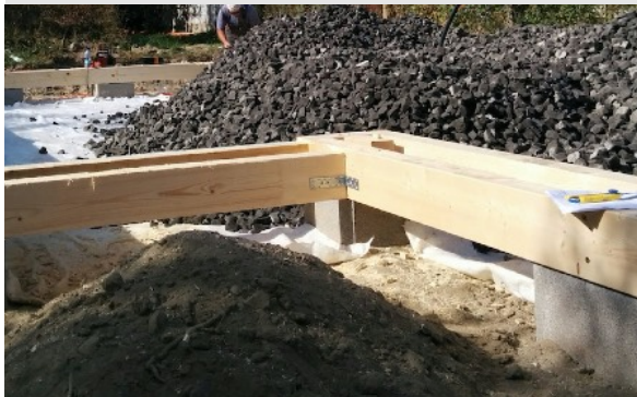
Medzi betónové tvárnice a drevený veniec sa vloží kus hydroizolácie. Drevený veniec sa vypodloží do roviny a uchyť k pripraveným pásom.
