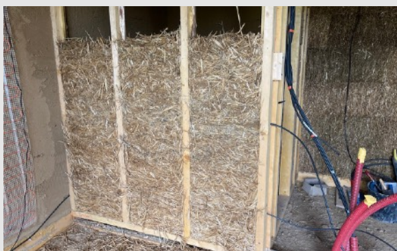
Po vyschnutí výplňovej zmesi sa dá priečka omietať hlinou. Omietku treba sieťkovať, aby nemala trhliny v mieste napojenia stojok a výplne.
