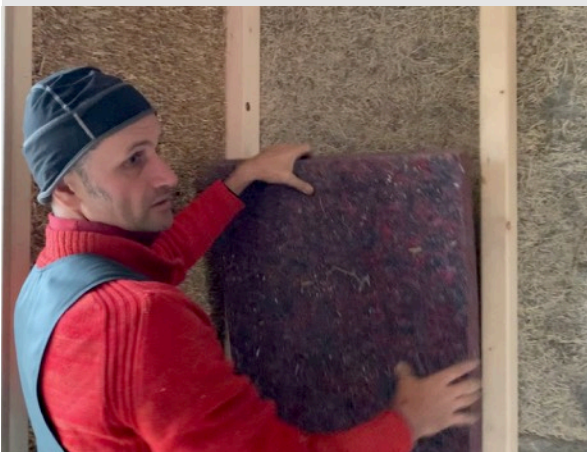
Na obrázku je drevený rám zaklopný slamovláknitou doskou, ktorá sa dá priamo omietať. Výplň priečky je z recyklovaného mäkkého panelu vyrobeného na Slovensku
