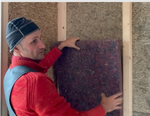
Na obrázku je drevený rám zaklopený slamovláknitou doskou, ktorá sa dá priamo omietať. Výplň priečky je z recyklovaného mäkkého panelu vyrobeného na Slovensku
