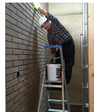
Priečka murovaná hlinenými tehliami na hlinenú maltu.
