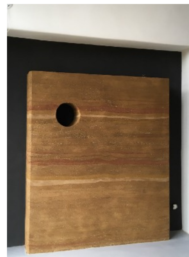
Nenosná priečka z ubíjanej hliny.
