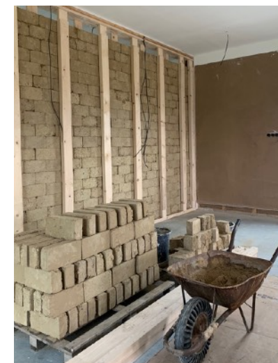
Stavba protipožiarnej a akustickej priečky medzi dielňou a apartmánom.
