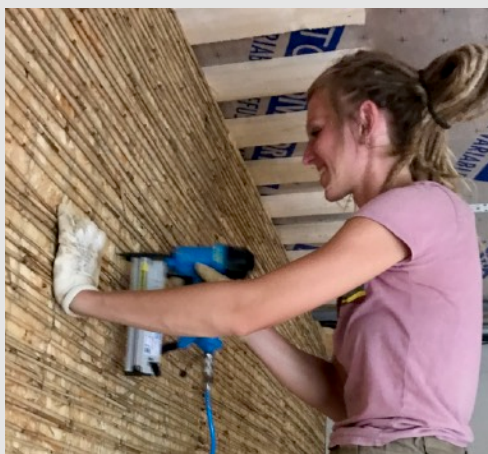
Ak sa ako záklop použije OSB doska a chceme ju omietnuť hlinenou omietkou, treba na OSB prichytiť rákosovú rohož ako nosič omietky.
