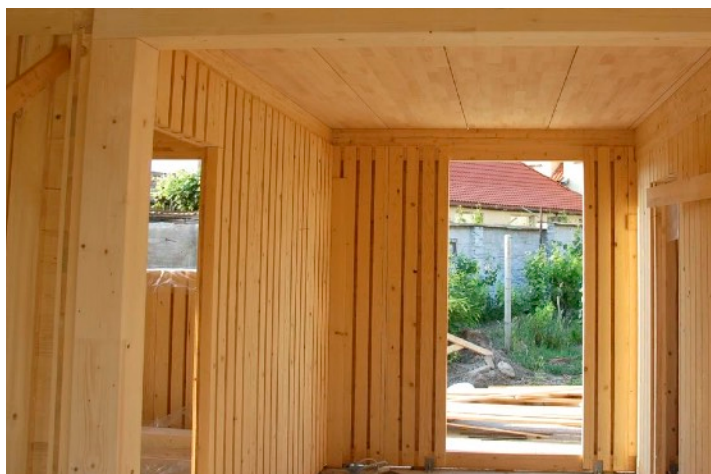
Priečky z drevených panelov. Na obrázku sú nosné priečky Lignotrend kde panely s medzerami umožňujú rozvod inštalácií na stavbe. Pohľadové plnodrevené CLT (Croos Laminated Timber) panely musia mať elektrickú inštaláciu zadanú už pri výrobe.
