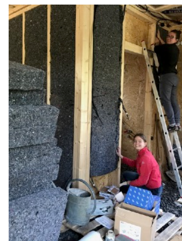
Výplň drevených rámov mäkkou textilnou izoláciou (alebo drevovláknou, konope). Priečka sa zaklopí z oboch strán OSB doskami.
