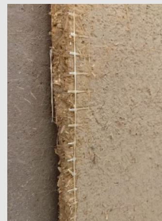
Pre suchú výstavbu sa dajú použiť/ priskrutkovať hlinené dosky.
